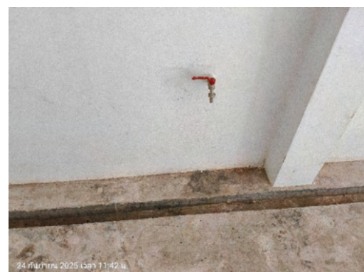
รางระบายน้ำไปยังระบบบำบัดน้ำเสีย
